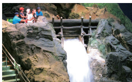
「鉄砲堰」切り出した材木を水の力で下流へ押し出すために作られた人工のダム
